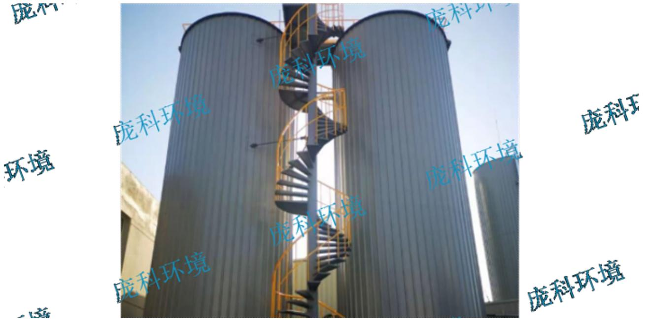
庞科环境厌氧反应器的产品施工及安装均采用标准化作业流程，公司制定了完整的标准作业流程SOP。客户环保项目签约后，庞科环境的设计和项目团队严格遵循公司的标准作业流程，首先完成规定范围内的设计工作，确保设计质量和安全满足规范，现场的SOP施工又保证反应器壳体制作的准确度和精确度，如罐体的圆整度，焊缝饱满圆润，材料的防腐性能，力学特性，温度的膨胀特性等都得到充分保证，工厂的SOP作业又确保加工及交付周期短，满足客户工程进度；广东EGSB厌氧反应器一般多少钱庞科环境正是通过跨专业的技术运用，结合自身的关键厌氧反应器技术，不断创新为客户提供资源回收手段。
